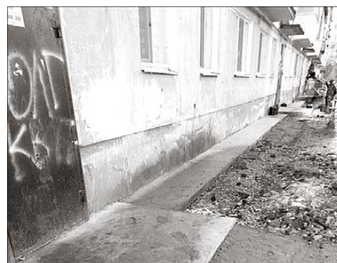
Бажова, 6, – отремонтирована отмостка и залиты крыльца
