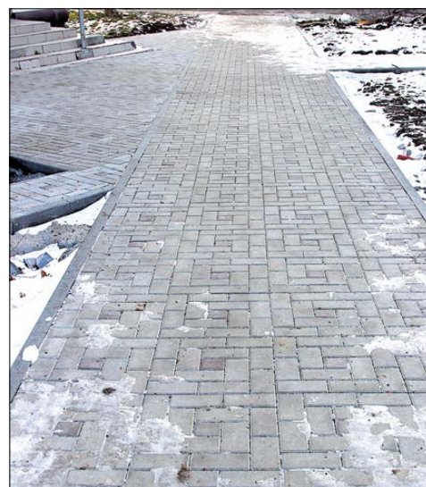
Пешеходные дорожки выложены тротуарной плиткой
