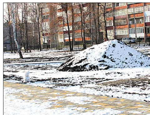
Размечены будущие газоны, завезён грунт для посадки деревьев
