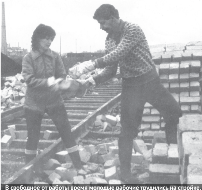
В свободное от работы время молодые рабочие трудились на стройке.
