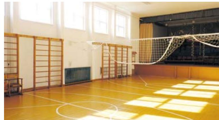
Школьный спортзал после ремонта
