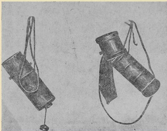
Фиг. 37. Общий вид противогаза Зелинского Московского образца: а) с нижней горловиной и пробкой, б) с жестяной крышкой снизу.
