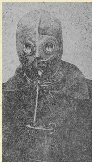
Фиг. 25. Противогаз Горного ин-та с шлемом Кумманта в надетом виде.
