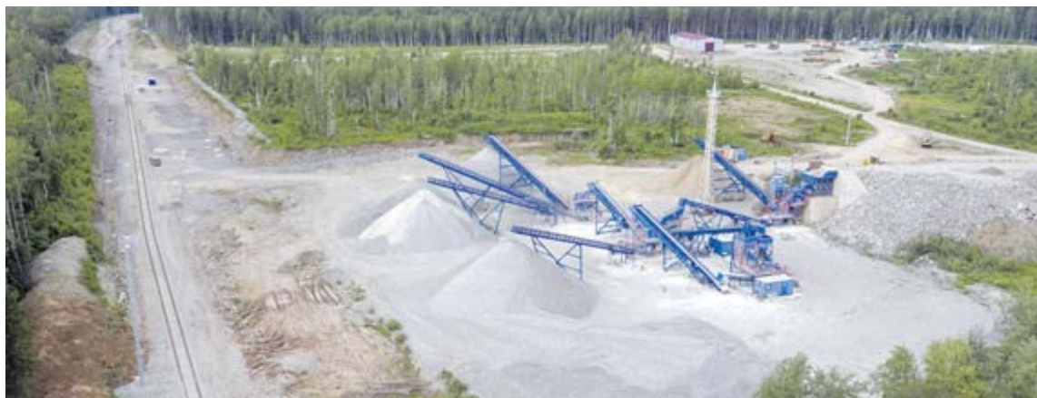
Пути подведены к дробильному комплексу RESTA
