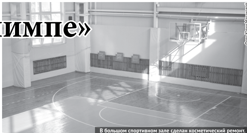
В большом спортивном зале сделан косметический ремонт.
