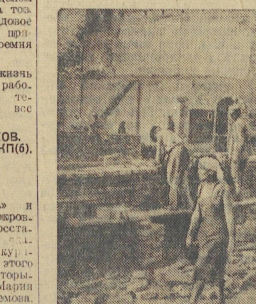
В строительстве Краснодарского театра принимают горячее участие широкие массы трудящихся города. На снимке слева: один из участков строительства, где работают домохозяйки города и молодые школьницы. Справа: колхоз им. Литвинова, Медоводского сельсовета, Тимашевского района, на 90 проц. выполнил план контракта скота. Телята содержатся в хороших условиях, обеспечены заботливым уходом. На снимке: телятина колхоза имени Литвинова Е. К. Каленцова среди своих питомцев.
