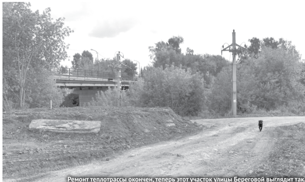
Ремонт теплотрассы окончен, теперь этот участок улицы Береговой выглядит так.
