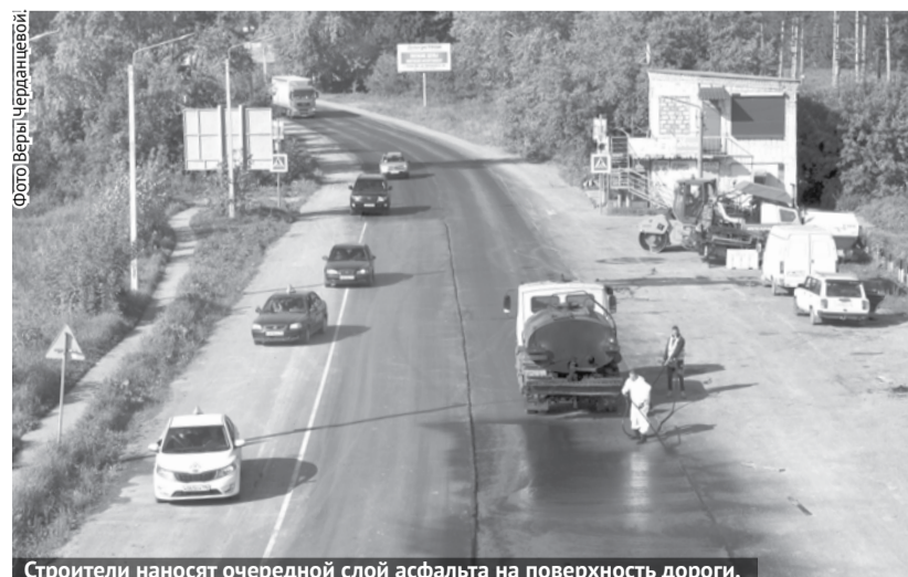
Строители наносят очередной слой асфальта на поверхность дороги.
