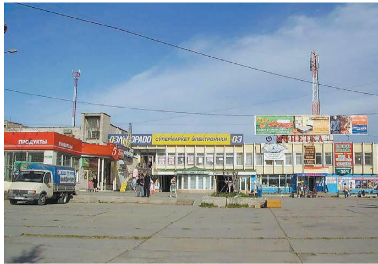
Так площадь выглядела до реконструкции.
