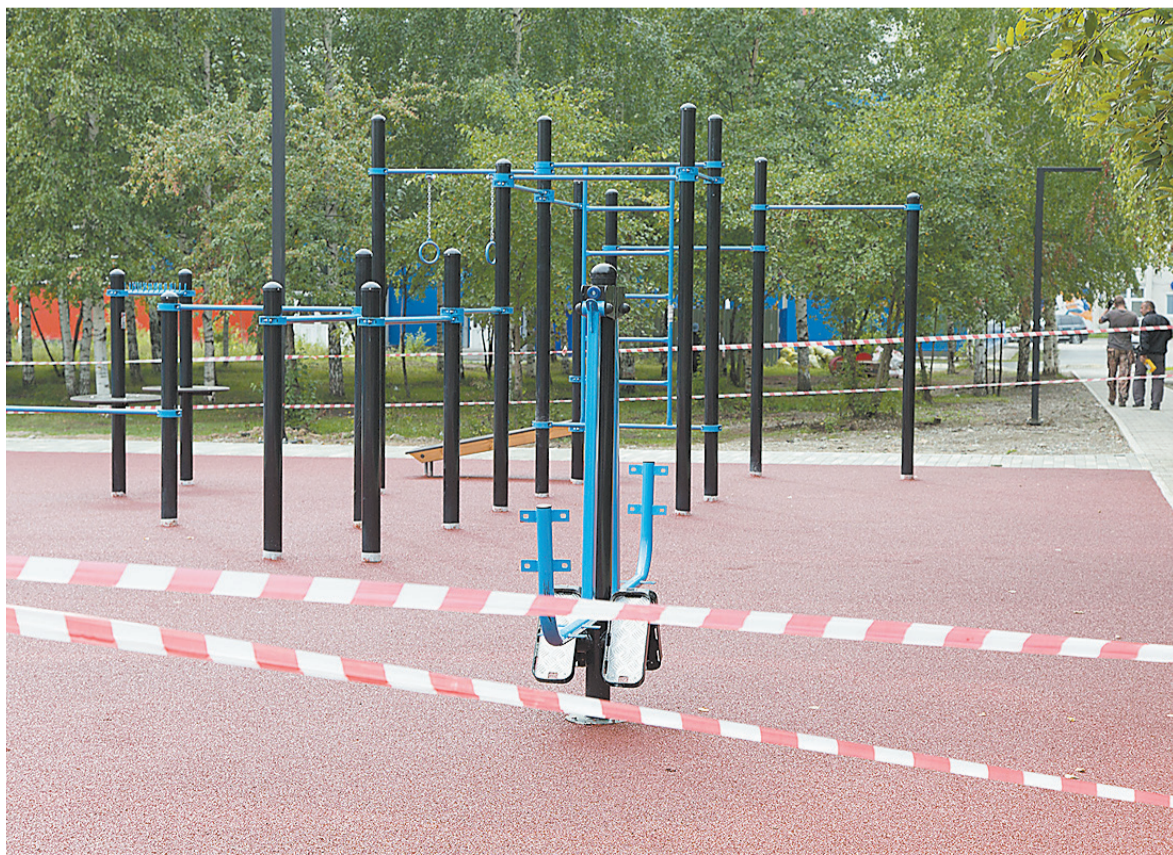
Спортивная площадка откроется, когда строители убедятся, что покрытие хорошо прижилось.
