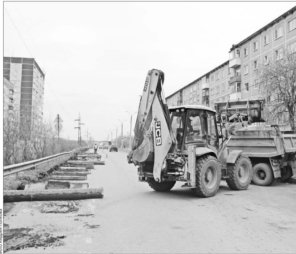
Идет демонтаж и вывоз отслужившего свое бордюрного камня
