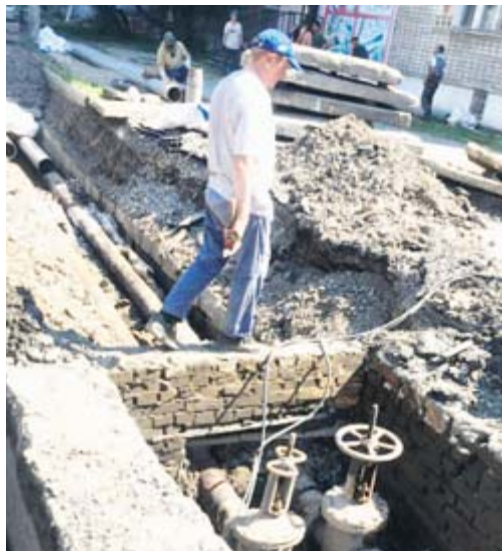
На улице Фрунзе было заменено 60 метров теплосетей в двухтрубном исполнении
