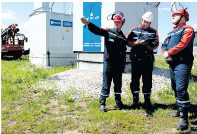
Строительно-монтажная бригада Алапаевского РЭС осматривает электросетевую инфраструктуру, которая питает объекты «Путиловского». Слева направо: электромонтёр Евгений Зуев, руководитель бригады Николай Могильников, электромонтёр Андрей Игнатъев.
