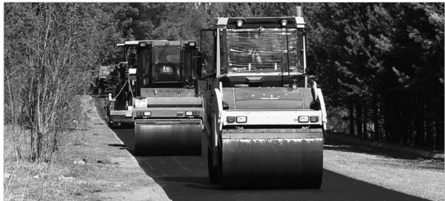
Непрерывное движение асфальтоукладчика обеспечивал бесперебойный подвоз асфальтобетона с Нижнетагильского асфальтового завода. Выравнивающий слой укладывали по одной полосе, чтобы не доставлять неудобства садинцам, едущим в сады и на дачные участки.
