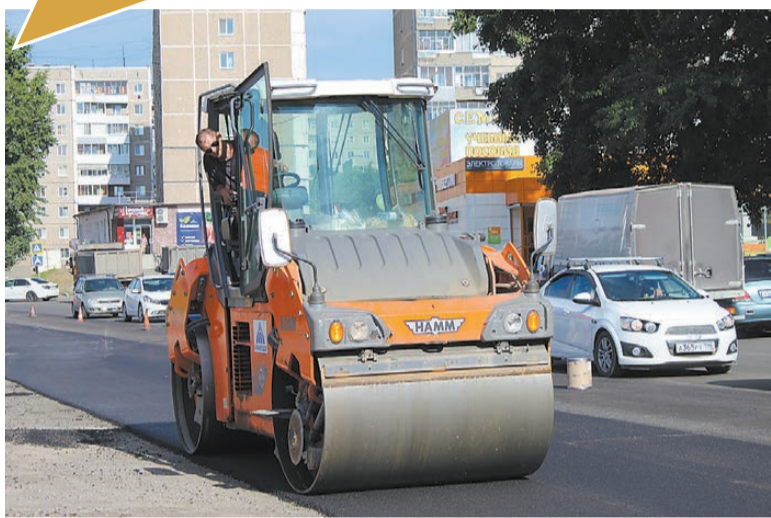
Каток утюжит свежий асфальт на Дружинина.
