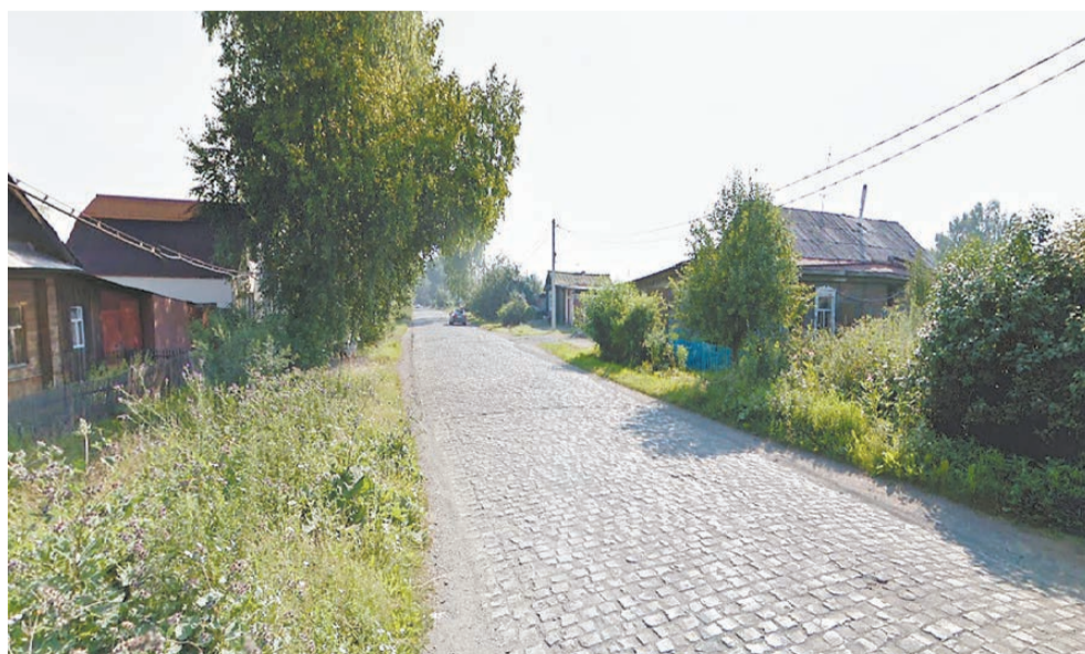
Бригадная до ремонта.
