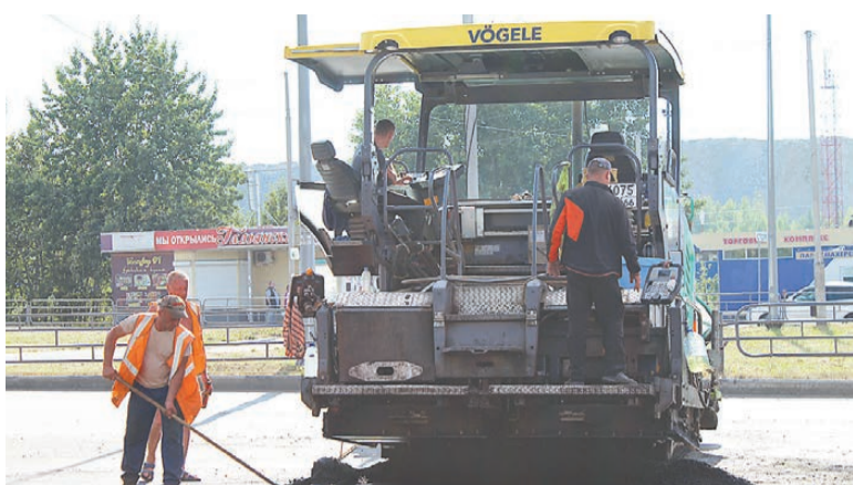
Асфальтоукладчик на пересечении Дружинина и Черноисточинского шоссе.
