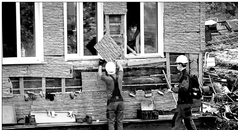
Восстановительные работы идут полным ходом
