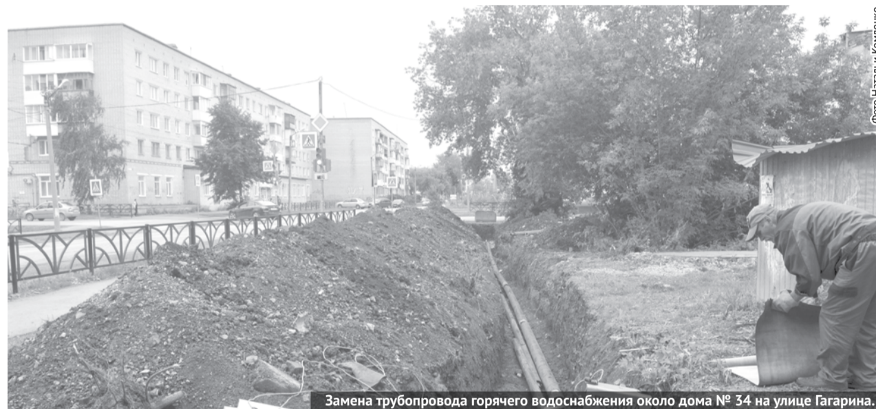
Замена трубопровода горячего водоснабжения около дома № 34 на улице Гагарина.
