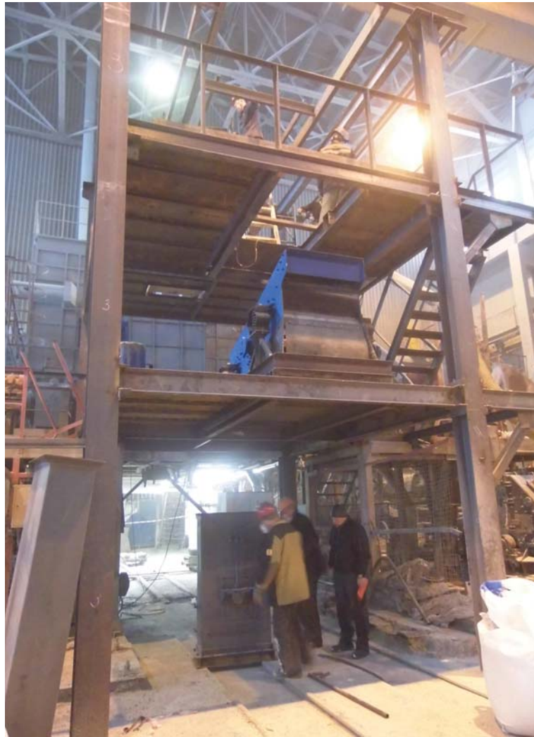
На участке по производству бокситомагнезиальных огнеупоров цеха № 1 смонтирована и работает новая дробилка.
