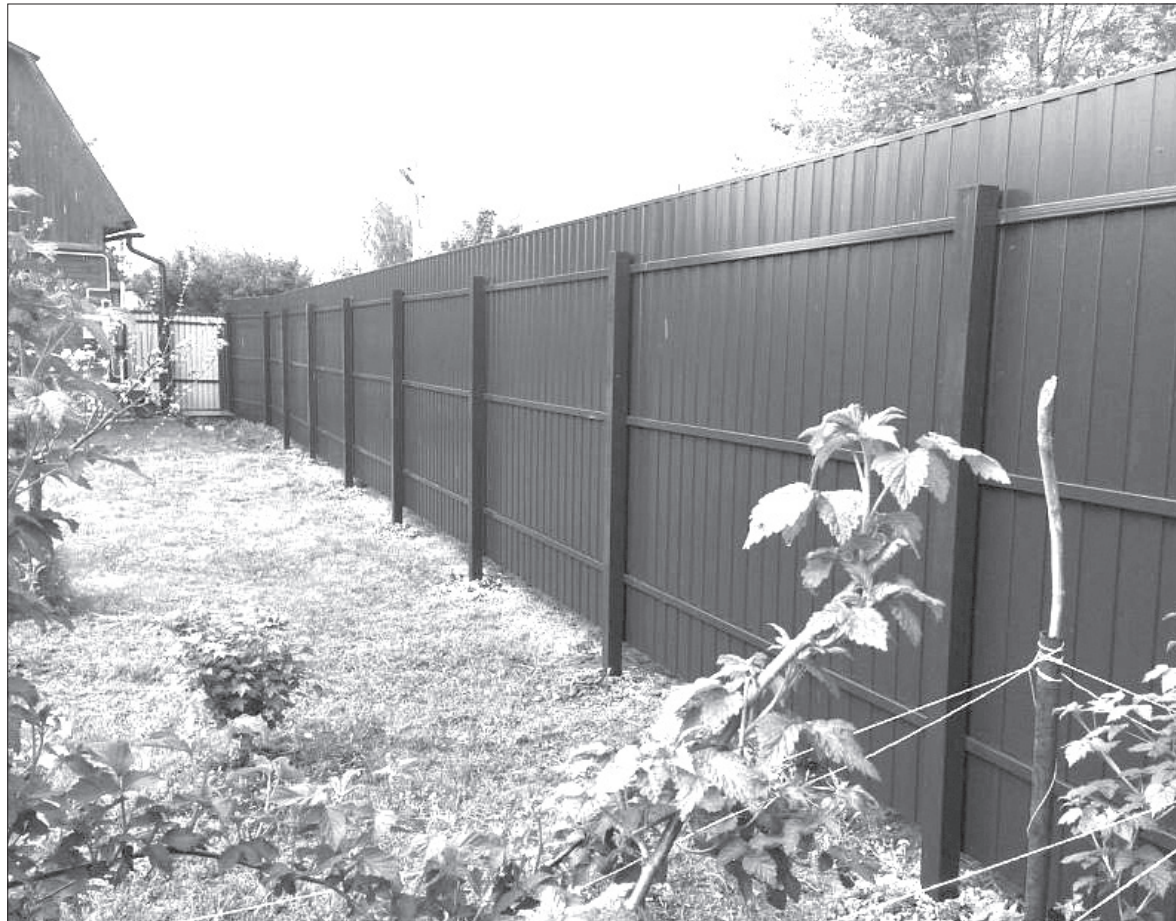
Глухие заборы допускается устанавливать между участками только по письменной договоренности между соседями / ФОТО С САЙТА M-STRANA.RU
