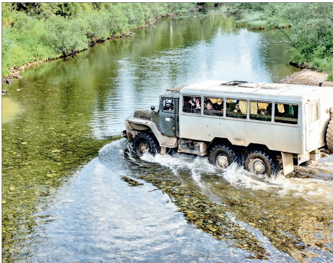
Мост разрушен, поэтому переправа идет по воде / ФОТО СЕРГЕЯ ЧИКИШЕВА
