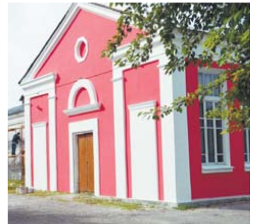
Отремонтированный фасад ДК Станкозавода
