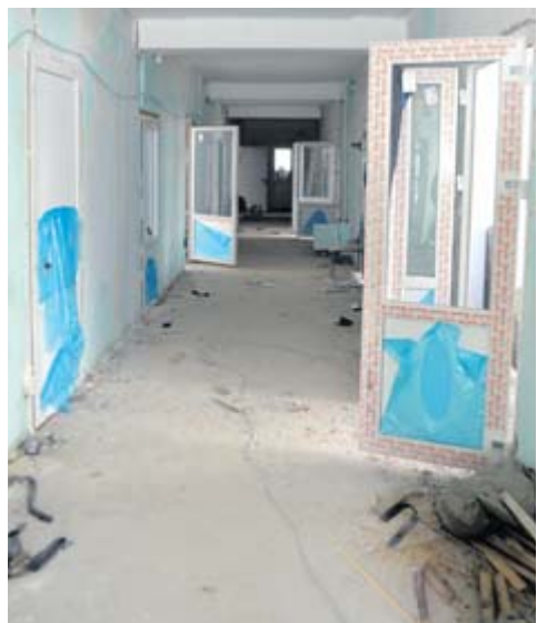
Ремонт в помещении будущего паллиативного отделения
