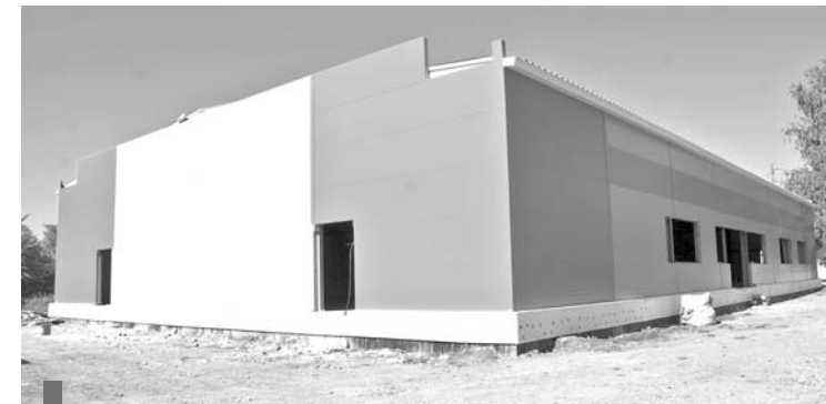
Строящийся объект на ул. Фучика, 1А
