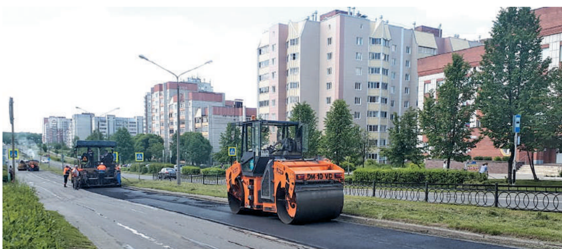
Завершение ремонта дорожного полотна на улице Ленина.
