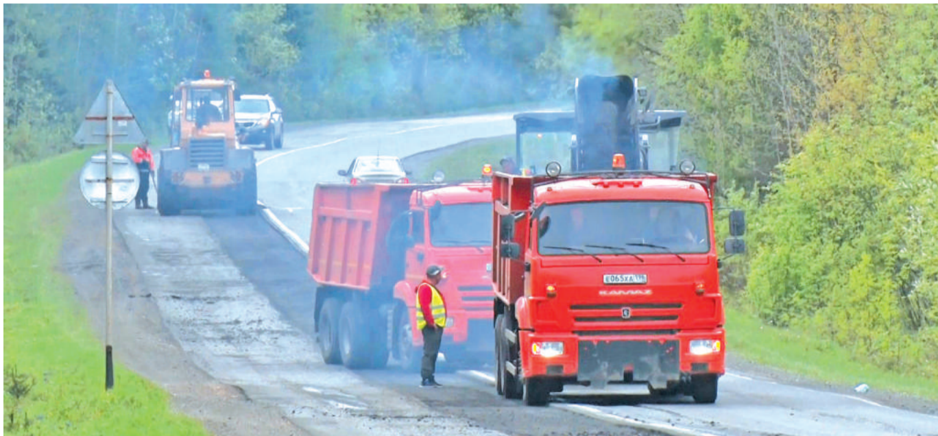
Ремонт улицы Нагорная – в приоритете коммунальщиков.
