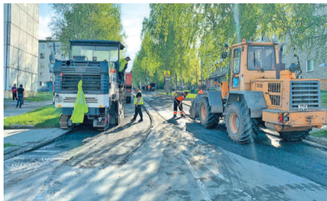
Коммунальщики проводят фрезерование дороги по улице Сиротина.
