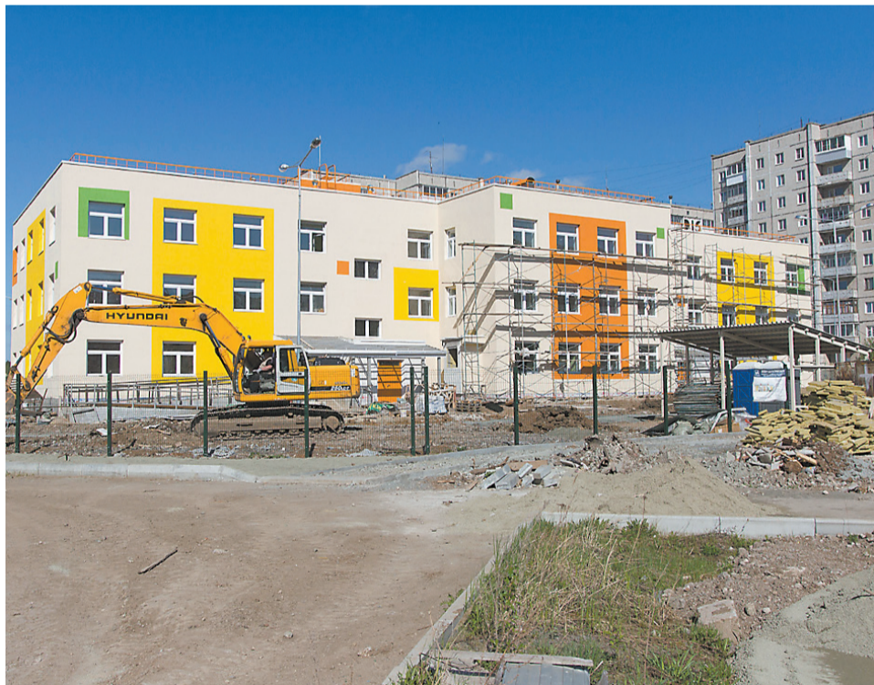
Часть строительных лесов в детском садике на Муринских прудах уже разбирают.
