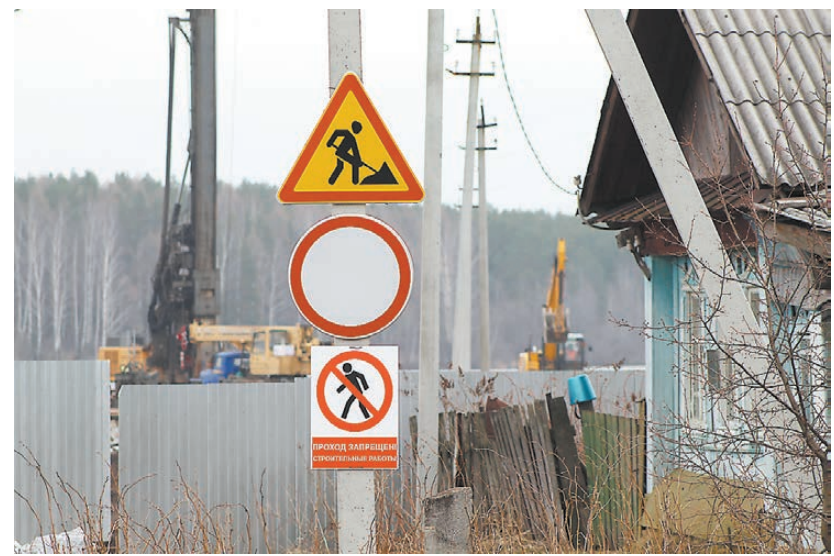
Проход запрещен, идут строительные работы.
