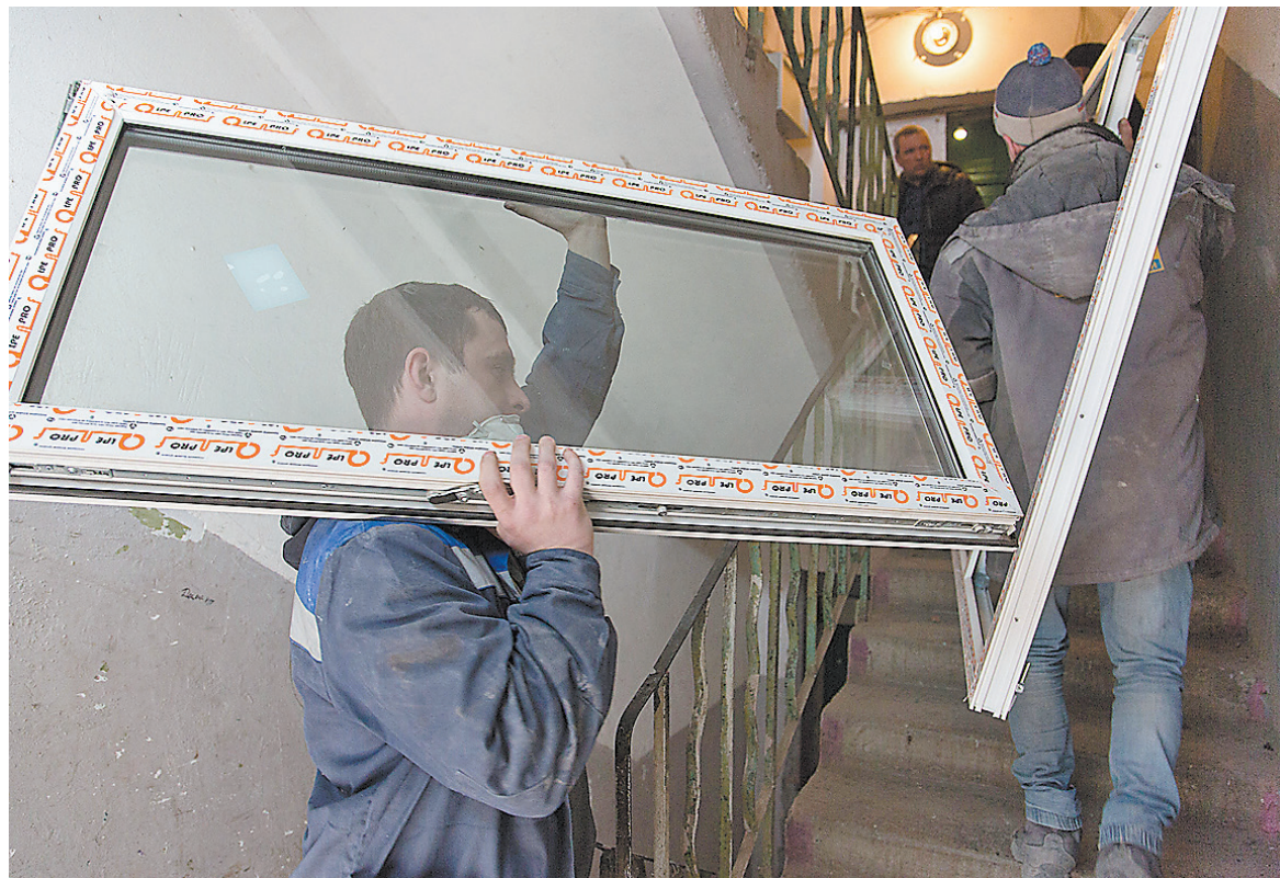
Внутри ведутся интенсивные работы.
