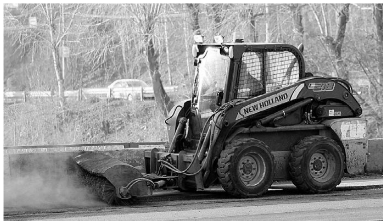
Очистка обочин дорог.
