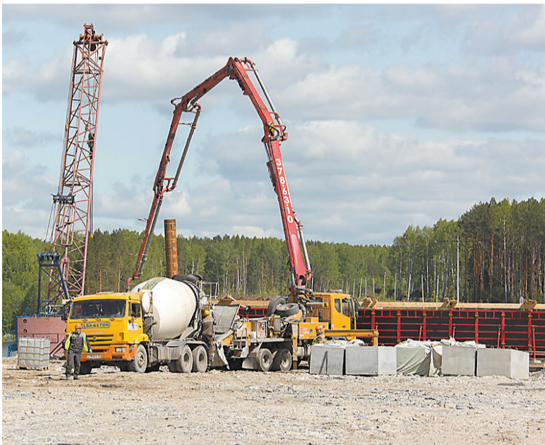
Заливка бетоном первой опоры будущего моста.
