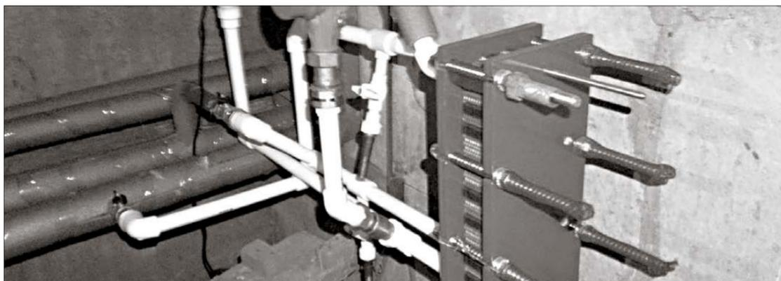
Нагрев холодной воды питьевого качества происходит при помощи теплообменника, установленного в подвале дома № 5 на улице Бажова
