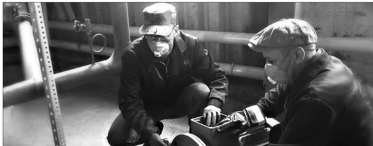
В котельной на 60 мегаватт южной части города идёт ремонт оборудования
