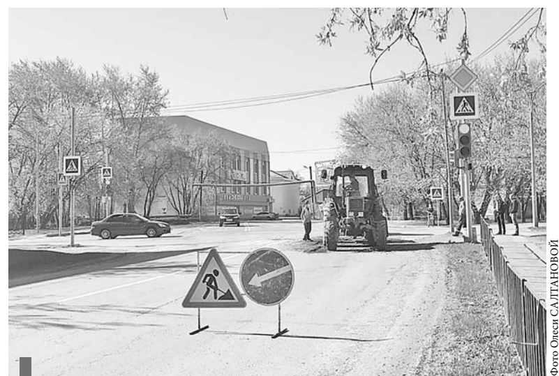
Ямочный ремонт на перекрестке ул. Кирова-Пушкинская
