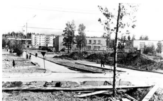
Начало строительства городской поликлиники
