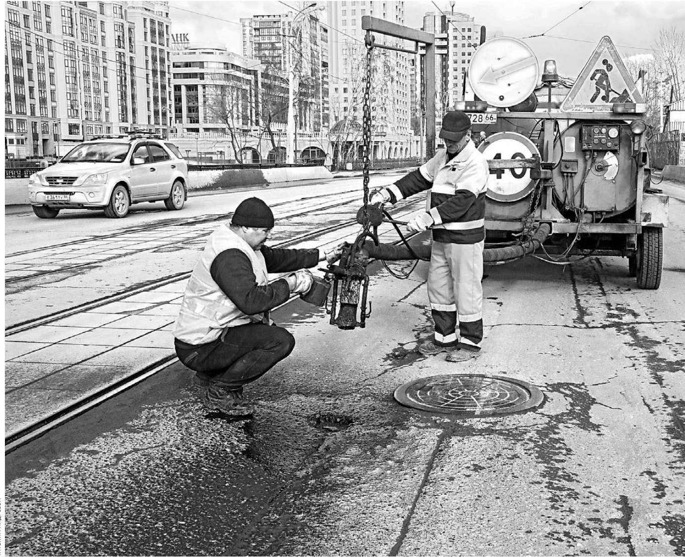
Традиционно дорожники начинают кампанию с ямочного ремонта.
