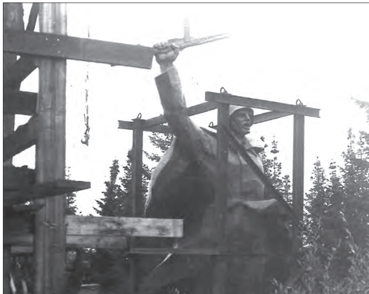
В фотоархиве редакции нашлась такая уникальная фотография периода реставрации монумента. Скульптура Солдата-победителя в специальном контейнере была спущена на землю / ФОТО ИЗ АРХИВА РЕДАКЦИИ ГАЗЕТЫ «ВРЕМЯ»
