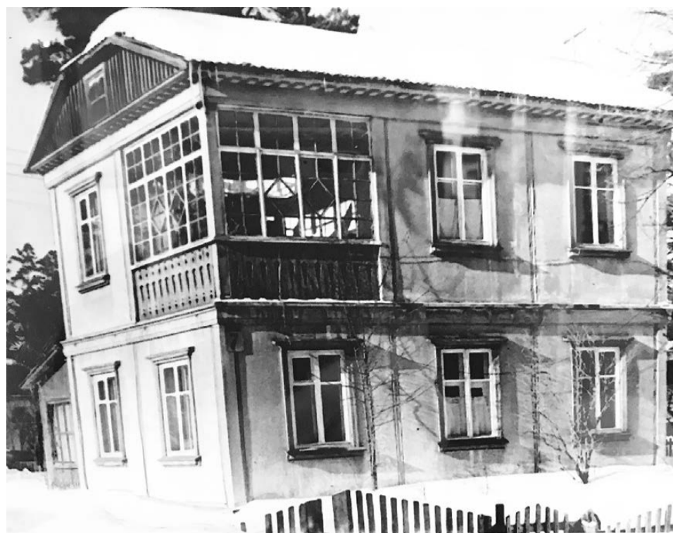
Первый двухэтажный крупнопанельный дом в СССР, построенный БЗСК. Фото 1945 года из фондов музея золота
