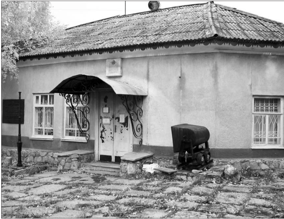
Облик здания музея до капитального ремонта
