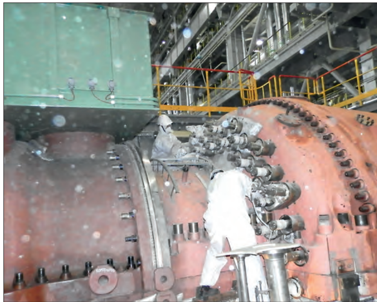
15 апреля. Ремонт газовой турбины блока № 1 / ФОТО ПРЕДОСТАВЛЕНО НТ ГРЭС
