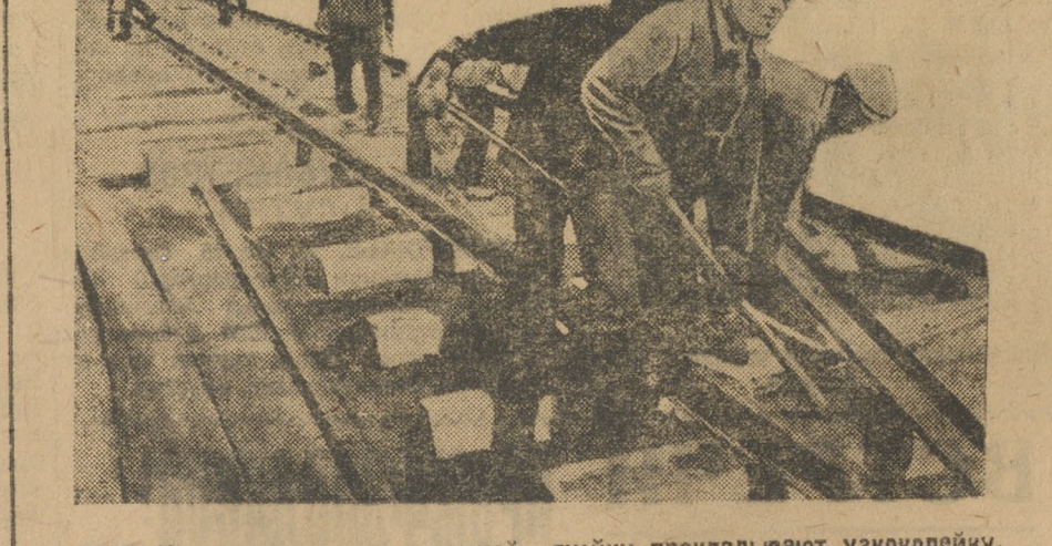
ВЛКСМ комсомольцы жел.-дорной линии прокладывает узкоколейку.
