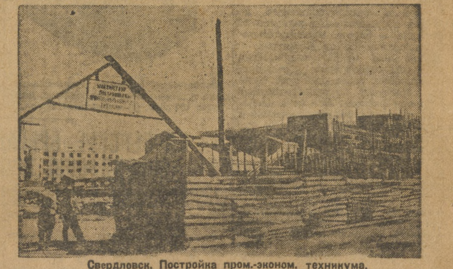
Свердловск. Постройка пром.-эконом. техникума.
