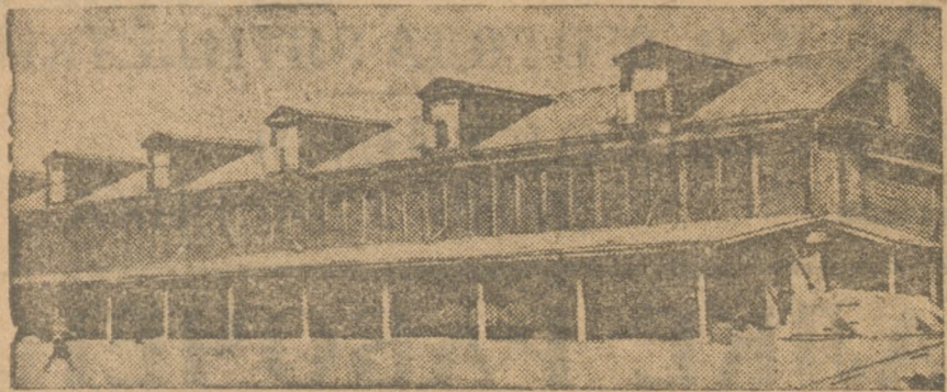
Чумлянский мельничный элеватор оборудован и отремонтирован.
