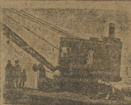
Экскаватор на Бакале.
