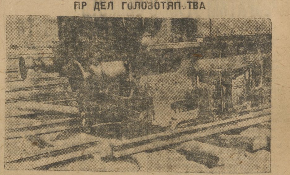
На Уралмашинстрое загнали паровоз на шпалы, где не укреплены рельсы. В итоге — 8 часов простоя.
