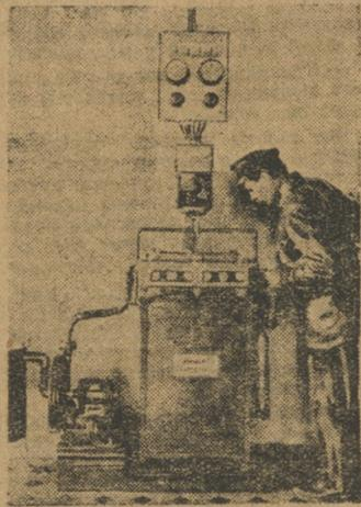
На Свердловском холодильнике установлена новая озонаторная станция, дающая 60.000 кубометров в час.
