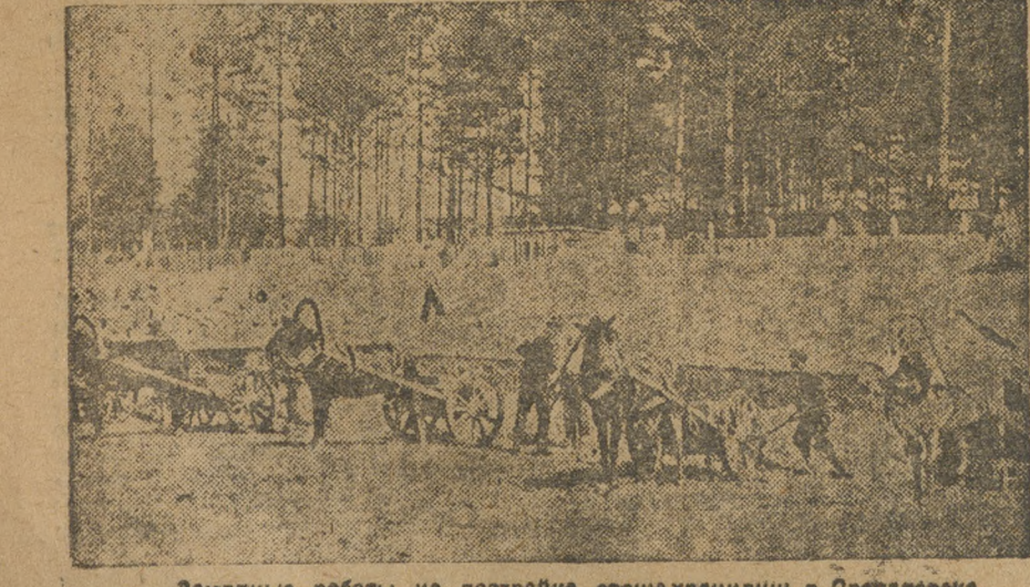
Земляные работы на постройке овощехранилищ в Свердловске.
