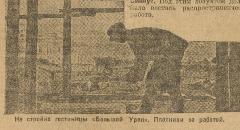
На стройке гостиницы «Большой Урал». Плотники за работой.
