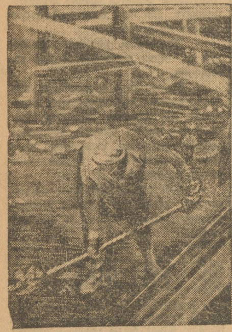
На строительстве. Земляные работы.
