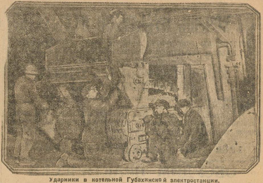
Ударники в котельной Губахинской электростанции.
