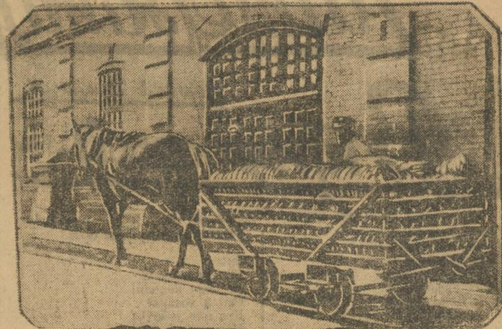
На Наслинском чугуно-литейном заводе все цеха соединены между собой узкоколейкой. На снимке — перевозка литья по узкоколейке внутри заводского двора.
