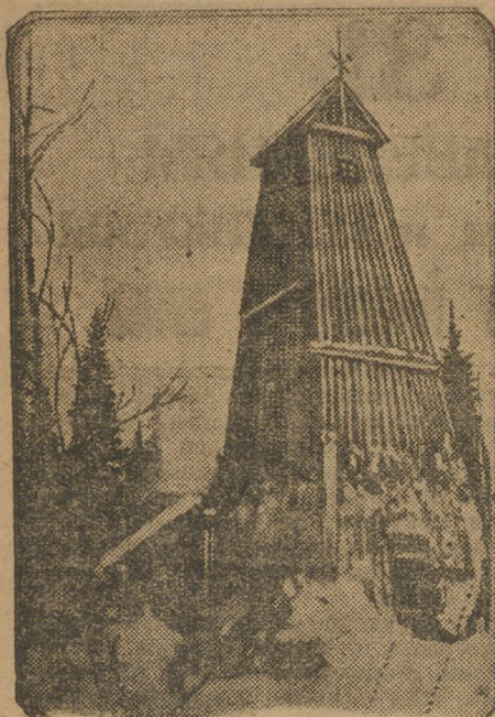
Вышка алмазного бурения каменно-угольных разведок близ Губахи.
