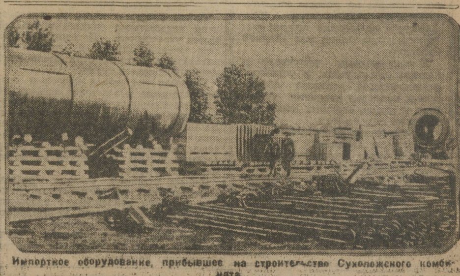
Импортированное оборудование, прибывшее на строительство Сухоложского комбината.
