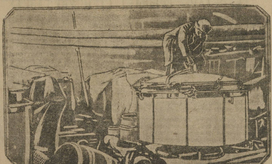
Установка котлов для варки пищи на фабрике-кухне. Котел будет нагреваться паром.
